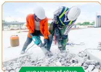
KHOAN ĐỤC BÊ TÔNG
